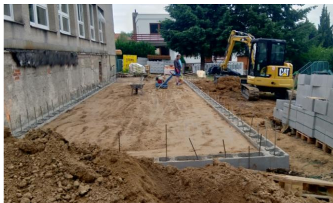
Práce na základovém pasu
