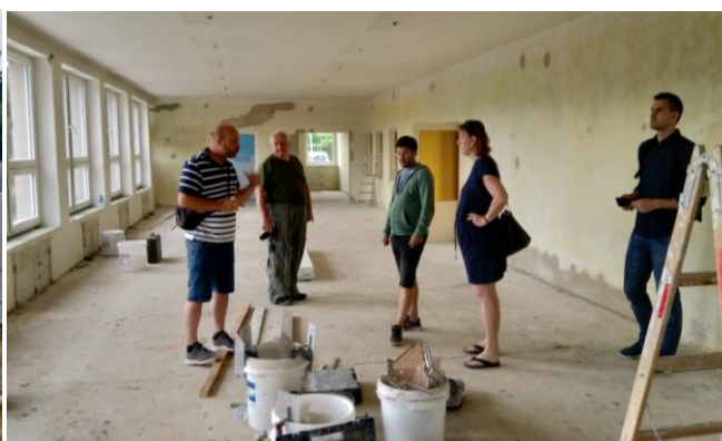
Kontrolní den na stavbě
