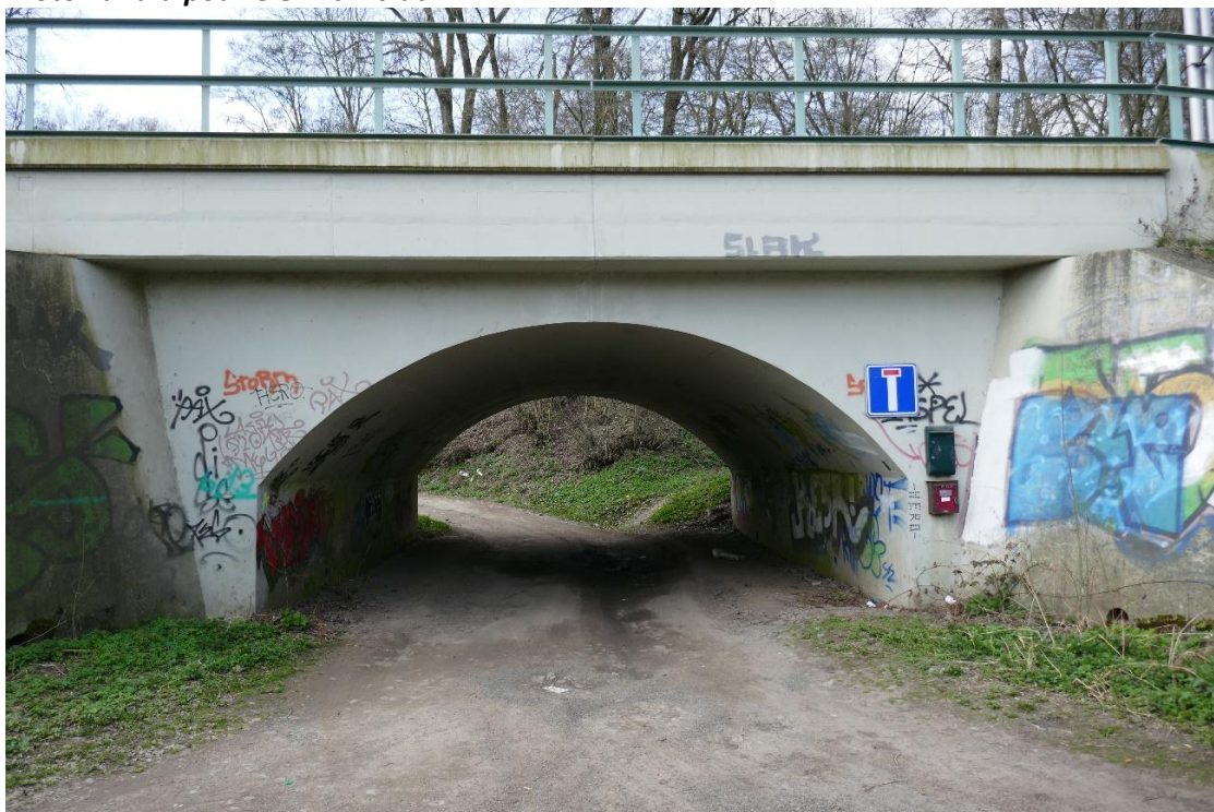
Foto kanálu pod železniční tratí
