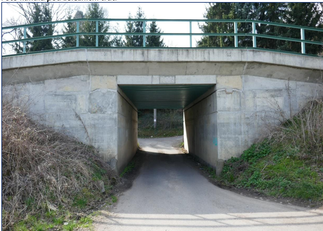
Foto kanálu pod železniční tratí
