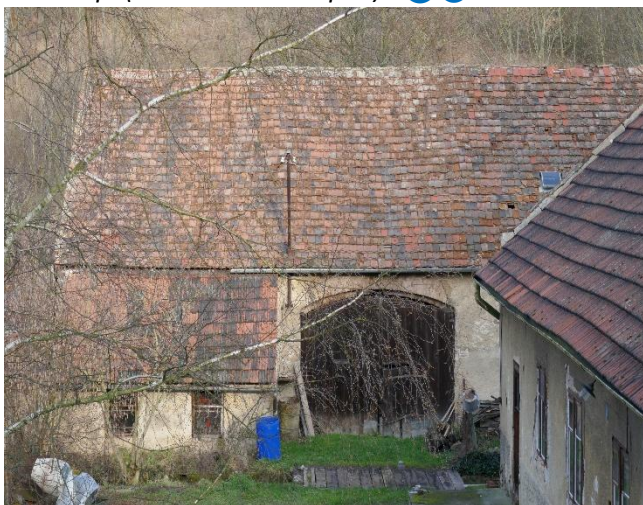
Bez č. p. (zem. stavba k č. p. 7) 5 20
