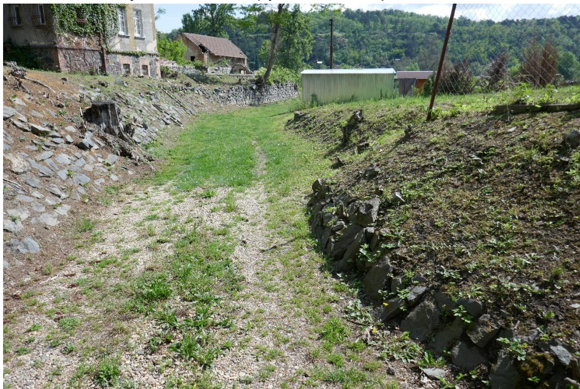
Svodnice, odvádějící vodu mimo dům (vyčištěná od náletů)
